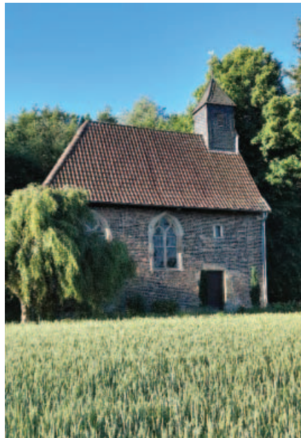
Die versteckt liegende Kapelle St. Antonius, erwähnt erstmals 1374. Das Gebäude und das Umfeld werden vorbildlich vom Langerner Schützenverein gepflegt.
